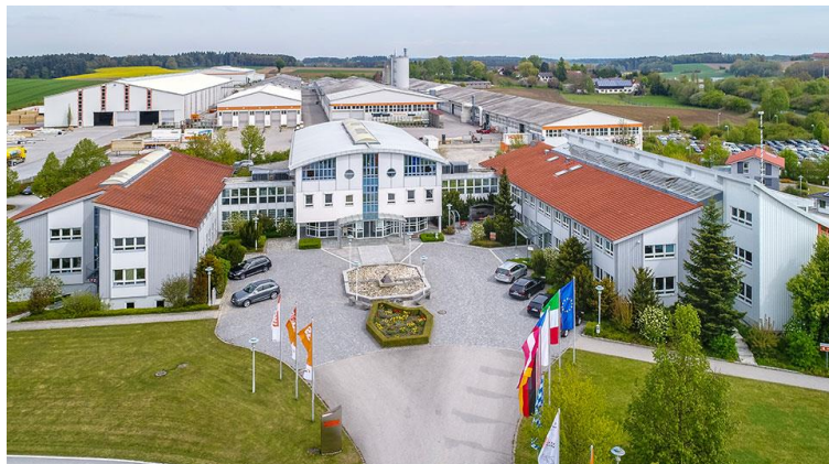
Bildtext: Haas Firmenzentrale Falkenberg - gute Auslastung, Baustellen ohne Einschränkungen, alle Kundentermine auf Plan
