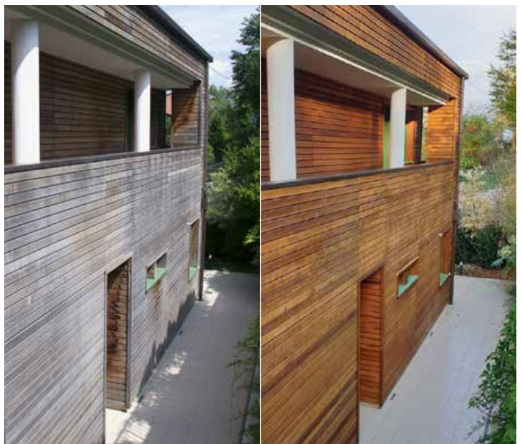
Das Passivhaus vor und nach der Sanierung
