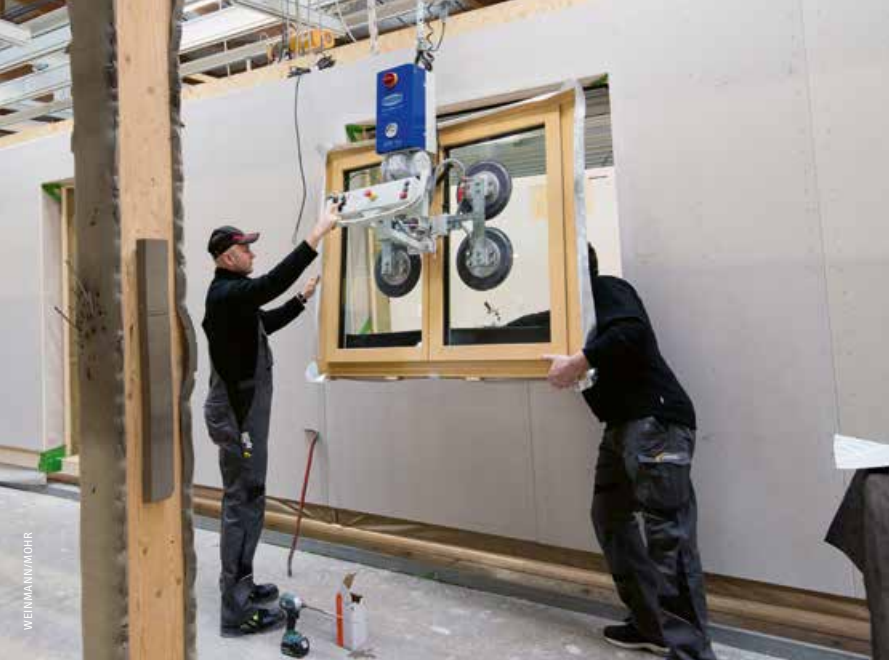
◀ Das Finishing mit Putzauftrag und Fenstereinbau erfolgt im Rungenlager
