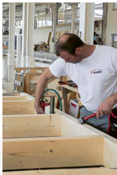
◀ Wandproduktion im österreichischen Großwilfersdorf
