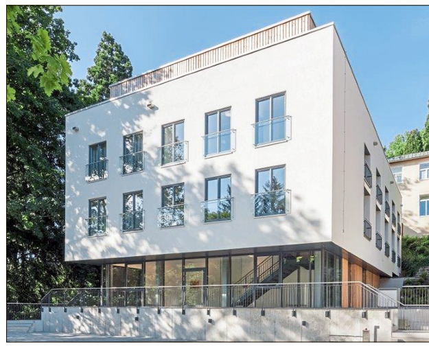
Das Unternehmen Haas ist dabei, das neue Geschäftsfeld Geschosswohnungsbau zu etablieren.
